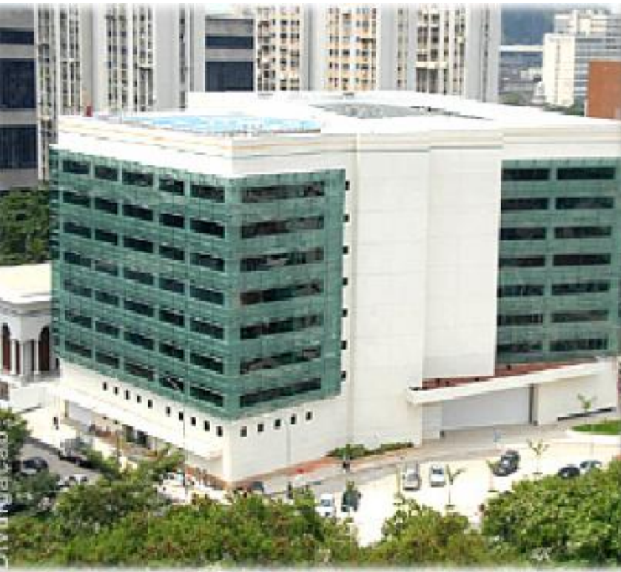
Prédio Bracor – Petrobras Cidade Nova – Certificado LEED CS – Certificated Outubro 2008
