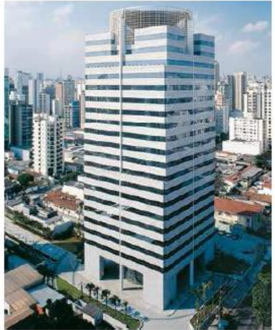
EDIFÍCIO NEW CENTURY SÃO PAULO
